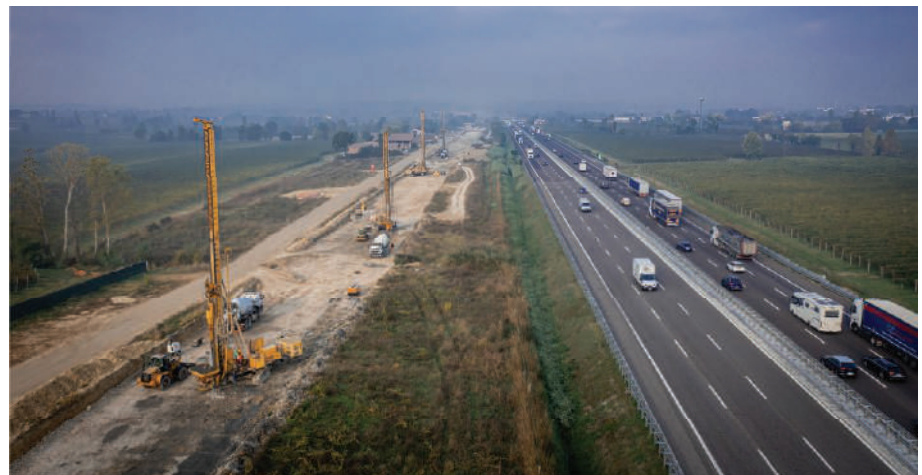
12. Realizacja kolumn wibrowymiany [4]
